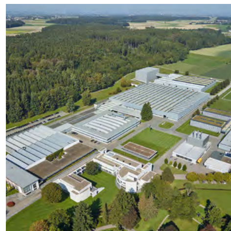
De volautomatische boilerproductie verzekert een gelijkblijvende hoge kwaliteit.
